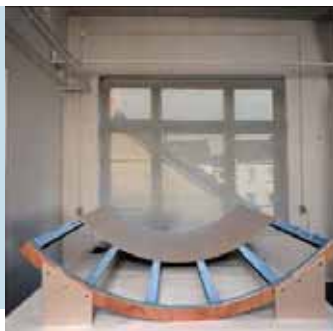
Изготовление элемента обшивки для криволинейной перегородки
