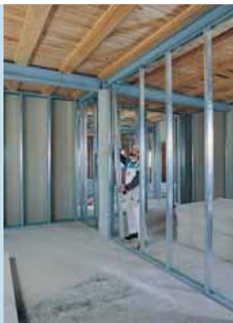
Установка металлического каркаса
