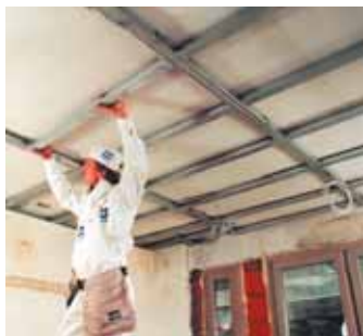
Установка несущих профилей каркаса
