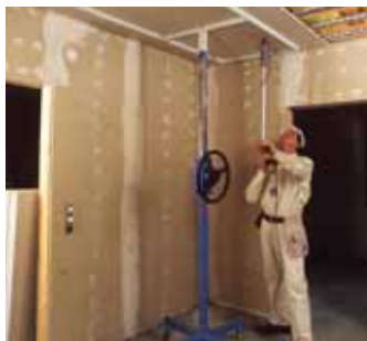
Установка КНАУФ-листов на готовом каркасе
