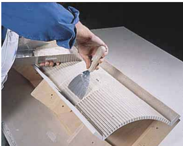
Лицевая сторона обрабатывается с применением КНАУФ-Унифлот или КНАУФ-Борд-Финиш.
