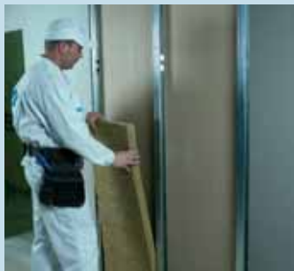
Укладка изолирующего материала
