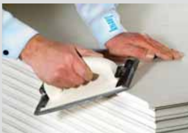
Возможные заусенцы на картоне следует удалить
