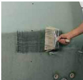
Грунтование с применением КНАУФ-Тифенгрунд производится щеткой
