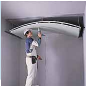
Установка и закрепление изогнутых листов обшивки
