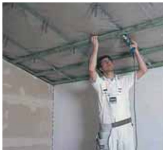
Установка основных профилей каркаса
