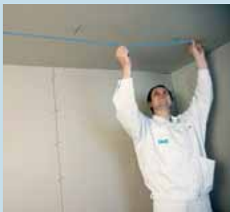
Разметка подвесного потолка
