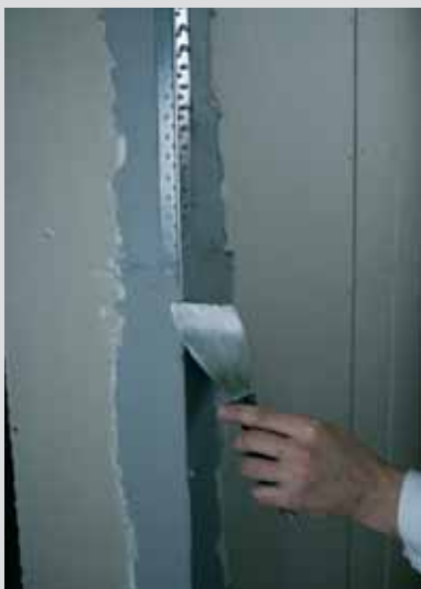
Шпаклевание внешнего угла
